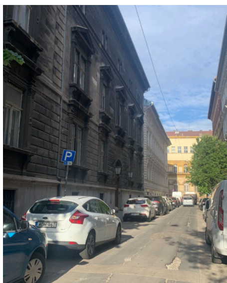
Figure 23: Photo personnelle prise le 26 mai 2025 avant les travaux de la rue Trefort, présence de parking le long des trottoirs et route abîmée
