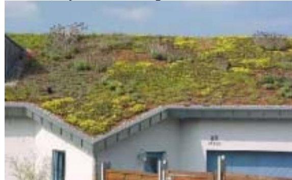
Zöld nyeregtető, Neuenstadt, Németország ( http://www.dachgaertner.de )
